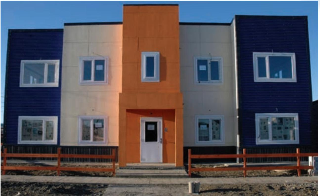
"A" (planta baja y primer piso) se ejecutaron con estructura independiente de hormigón armado y cerramiento de tabique estructural liviano.
