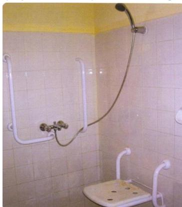
• En el área de ducha, se colocará una silla de material flexible, rebatible, diseñada para facilitar el uso de la ducha en posición de sentado, antideslizante, antiséptica y desarmable para su limpieza, con ducha manual a su lateral, optimizando el área de movilidad en el baño y facilitando el aseo del usuario.
